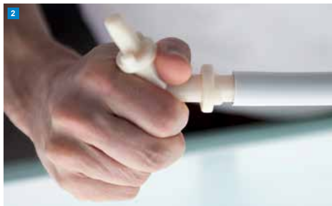
Kalibrace Před montáží tvarovky je nutné kalibrovat konec trubky.
