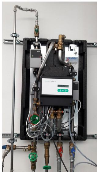
Gracias a la instalación de las estaciones de producción de ACS, a los ahorros energéticos conseguidos (≈25%), se unen los ahorros en el mantenimiento de la instalación y la tranquilidad por parte de la propiedad de que el agua que usan sus clientes es siempre agua proveniente de la red de abastecimiento, sin acumulación ni estancamiento, independientemente de nivel de ocupación que tenga el hotel.
