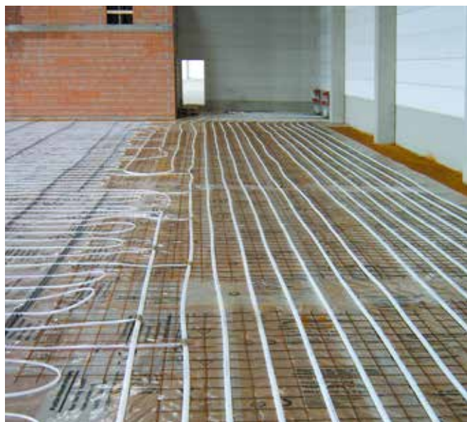
Połączenie obiegów grzewczych o tej samej długości z przewodami rozdzielczymi Uponor w układzie Tichelmann'a.
