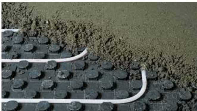
Dodatki do wylewki Uponor Multi uzupełniają standardową wylewkę betonową zgodnie z normą DIN 18560, tworząc wylewkę grzewczą - dla optymalnego przekazywania ciepła, szybkiego wiązania i wysokiej nośności statycznej.
