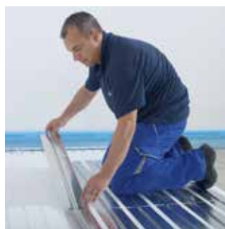
Płyty promieniujące przewodzące ciepło Siccus wkłada się w obliczonym rozstawie do kanałów prowadzących rury w gotowych panelach instalacyjnych Siccus.
