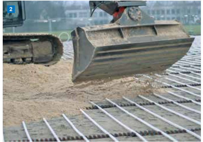
Wytrzymałe rury Uponor PE-Xa systemu ogrzewania boisk.
