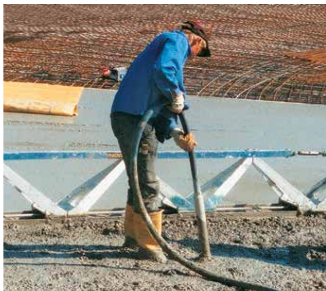
Zagęszczanie betonu przy użyciu kolb wibracyjnych
