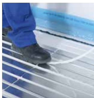
Rury systemu Uponor są następnie wciskane w kanał płyt promieniujących przewodzących ciepło.
