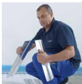
W razie potrzeby płyty promieniujące przewodzące ciepło Siccus można bez użycia narzędzi skrócić w miejscach wstępnego nacięcia.
