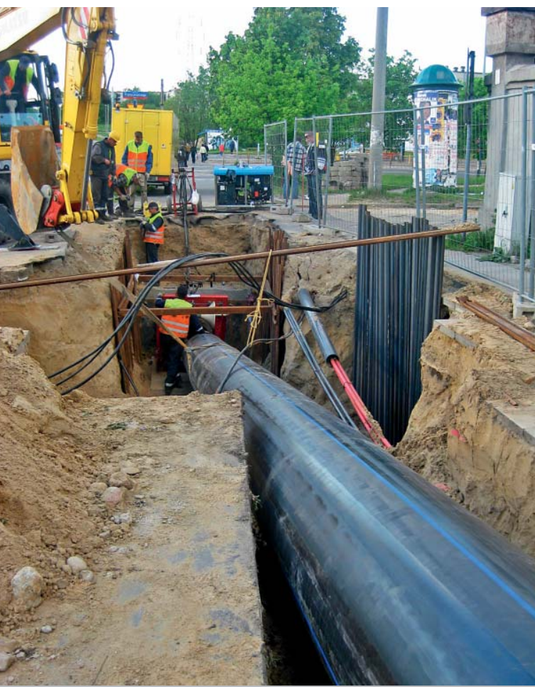
Fot. 2. Wykop nadawczy
