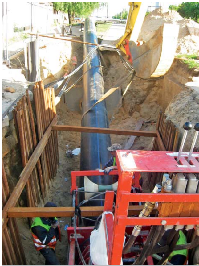
Fot. 3. Urządzenie do zawężania średnicy rury PE
