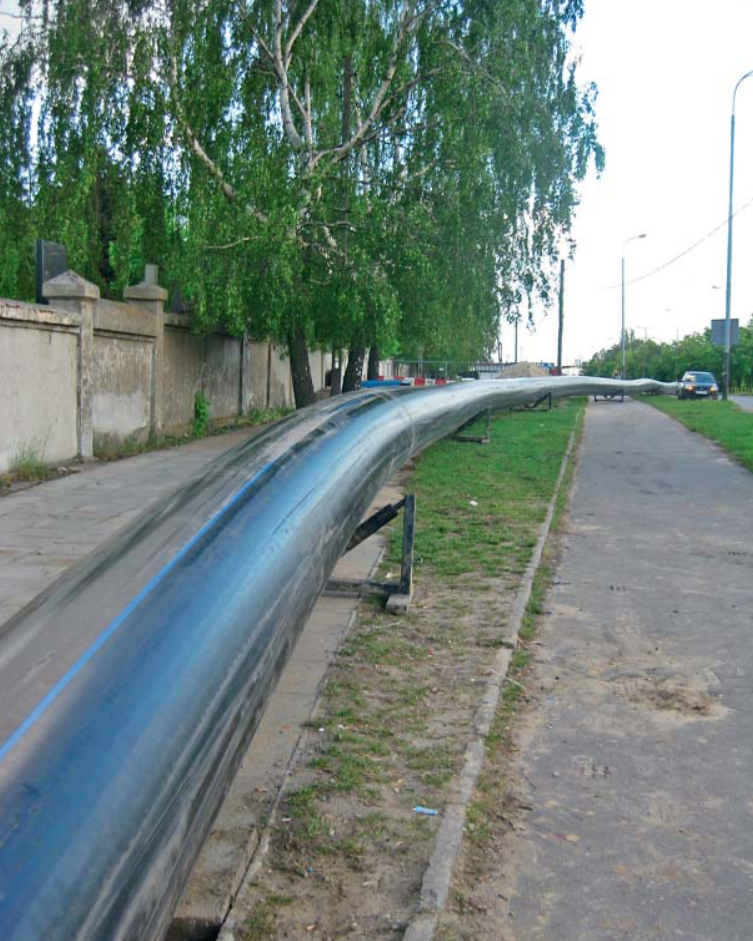
Fot. 1. Odcinek rury PE przygotowany do instalacji swagelining
