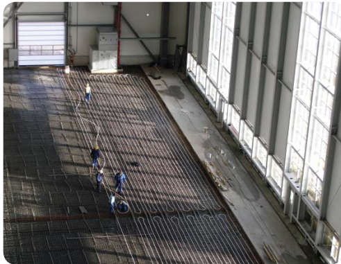
Hangar de aviones de 12.000 m 2 . (Alemania)
