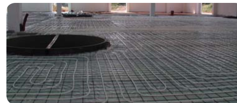
Fijación de la tubería brida plástico
