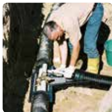
Még a kis hajlítási sugár sem jelenthet fektetési problémákat
