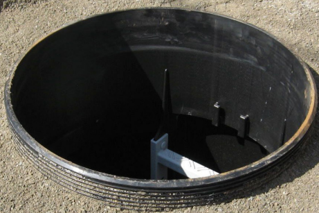
Komprimering runt konan
