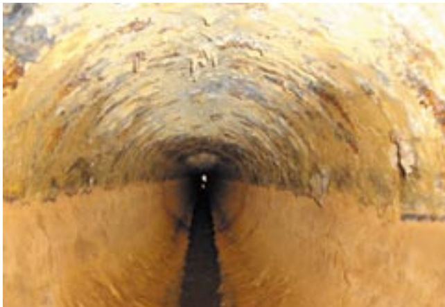
Fot. 4, 5. Porównanie powierzchni wewnętrznej kanału przed i po czyszczeniu
