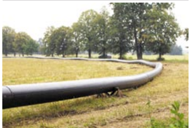
Fot. 7. Przygotowany do wprowadzenia odcinek rurociągu
