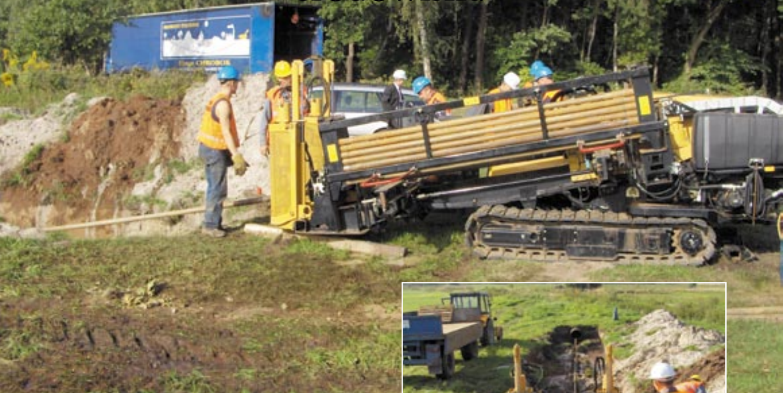
Fot. 1. Prowadzenie żerdzi pilotażowej
