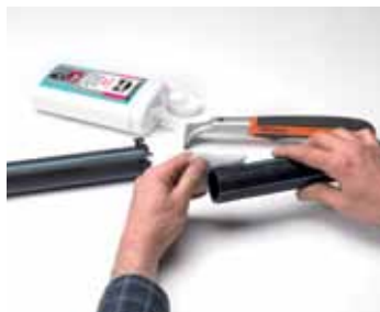
Avfetting av rør
