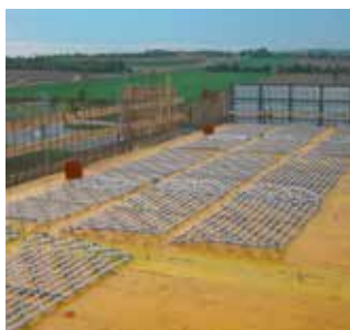
Umístění prefabrikovaného modulu Contec ON na bednění podle výkresu.
