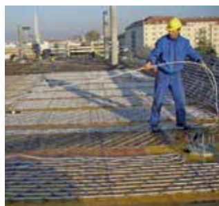
Alternativa: Pokládka potrubí Uponor PE-Xa do prázdného modulu Contec ON na staveništi.
