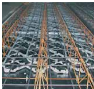
Betonový prefabrikovaný díl s Contec ON do připraveného betonu.
