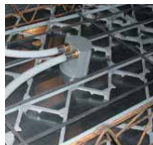
Zabudování tepelné zásuvky Contec T2 do betonáže
