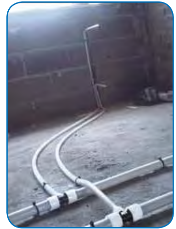
Figura 4. Instalación de sistema de calefacción por radiadores con tubería Uponor Comfort Pipe PLUS mediante tees Uponor Q&E y con el Uponor Smart Aqua codo salida radiador Q&E.
