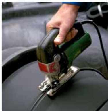
10 a. Opføringsrøret saves over i sporet.
