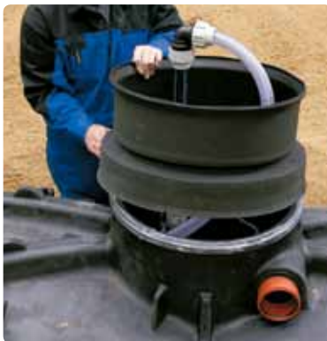
10 b. Gummiringen til opføringsrøret monteres på tanken, smøres og nederste del af opføringsrøret monteres med mærket IN over indløbet.
