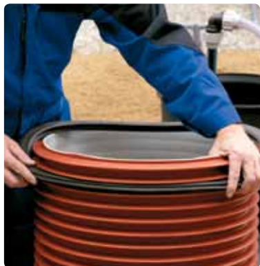
10 d. Tætningsringe monteres i 2. spor i begge ender af det ribbede forlængerrør.
