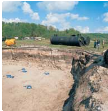
40 m 3 bundfældningstank klar til installation på Rosenvold Camping, Vejle.
