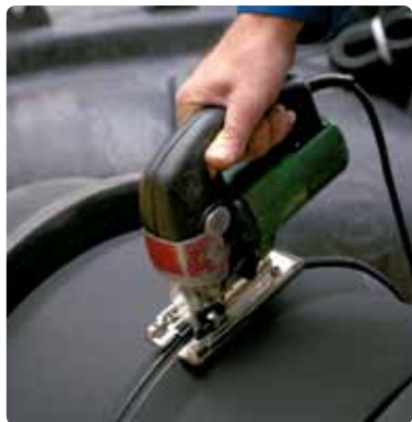
10 a. Opføringsrøret saves over i sporet.
