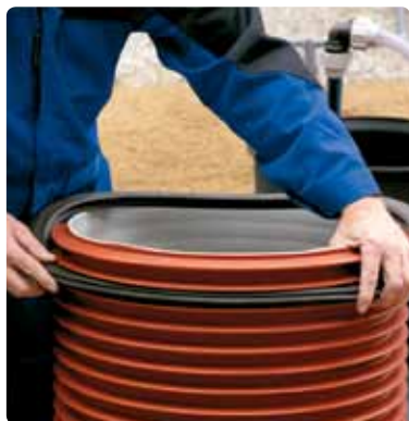
10 d. Tætningsringe monteres i 2. spor i begge ender af det ribbede forlængerrør.
