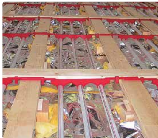
Flächen-elastischer Sportschwingboden mit integrierter Uponor Schwingbodenheizung
