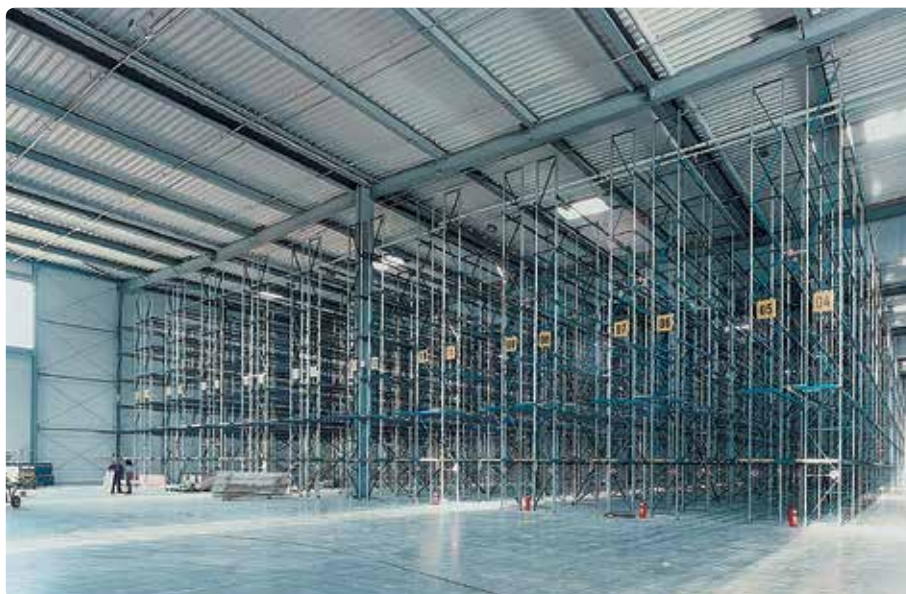
20 000 m 2 systemu ogrzewania podłóg przemysłowych w magazynie wysokiego składowania Uponor w Huckelhoven, Niemcy
