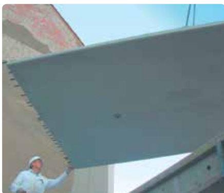
Montaż prefabrykowanych elementów sufitu
