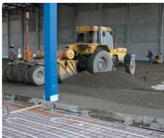
Używanie betonu ubitego
