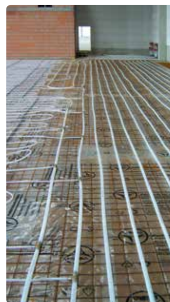
Podłączenie do systemu rur zbiorczych/rozdzielczych Tichelmana.
