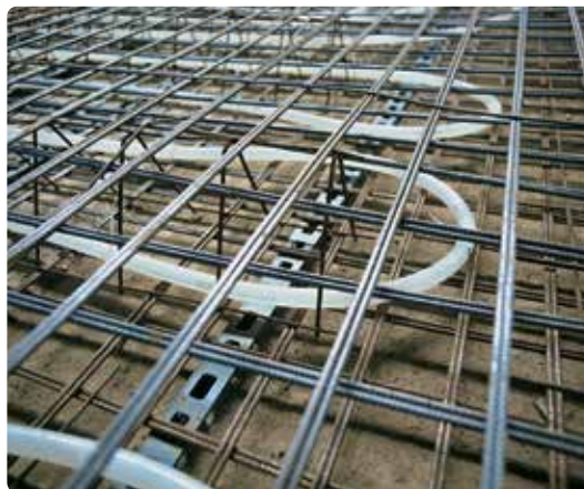
Beton zbrojony z siatką wzmacniającą
