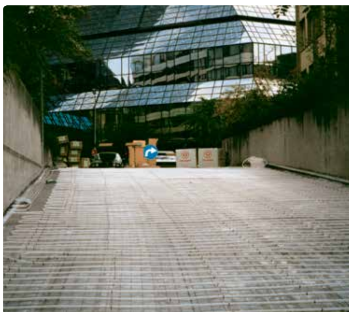
Bezpieczeństwo z systemem ogrzewania powierzchni zewnętrznych Uponor PE-Xa w trakcie zimy na wjazdach do parkingów podziemnych
