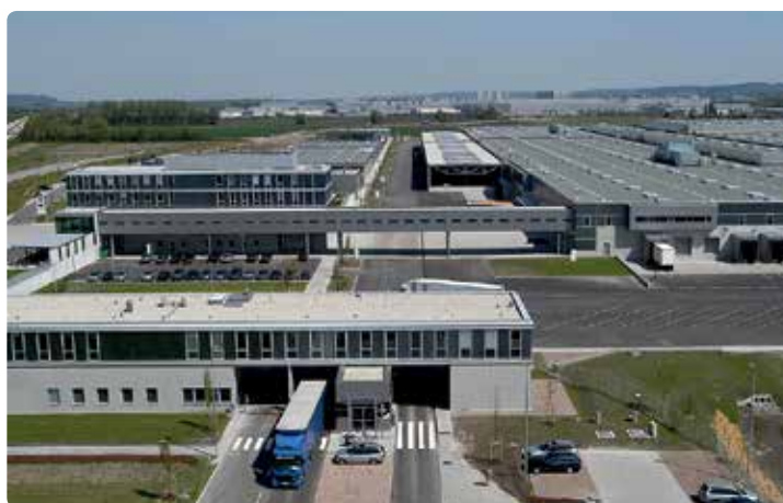
BMW Centrum Dynamiczne, Dingolfing, Niemcy. Wyposażony w System ogrzewania podłóg przemysłowych Uponor.
