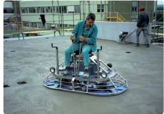
Zacieraczka wygładza powierzchnie betonowe
