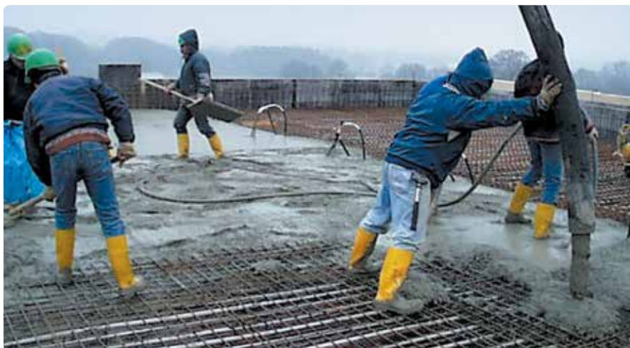
Wylewanie stropu betonowego
