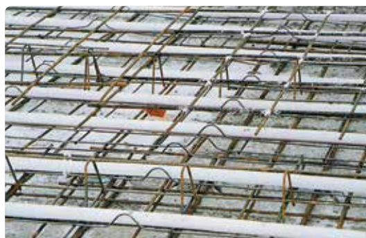
Moduły Contec umiejscowione na nośnikach siatki
