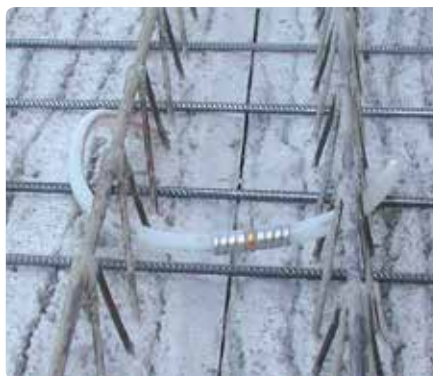
Podłączanie modułów Contec ON przy użyciu stałych złączek zaprasowywanych Uponor
