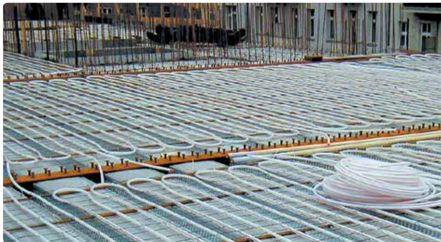
Moduły Uponor Contec montowane na stropie trapezowym z cienkiej blachy stalowej
