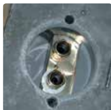
Widok od spodu, usunięta płytka przykrywająca
