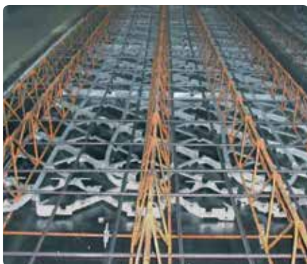
Konstrukcja sufitu przygotowana do wstępnej fazy betonowania
