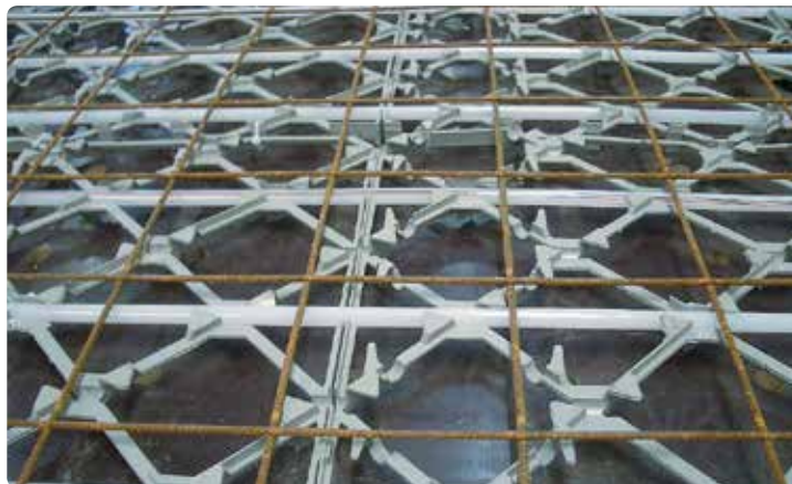
Contec ON wersja standardowa montowana na szalunku przy powierzchni sufitu
