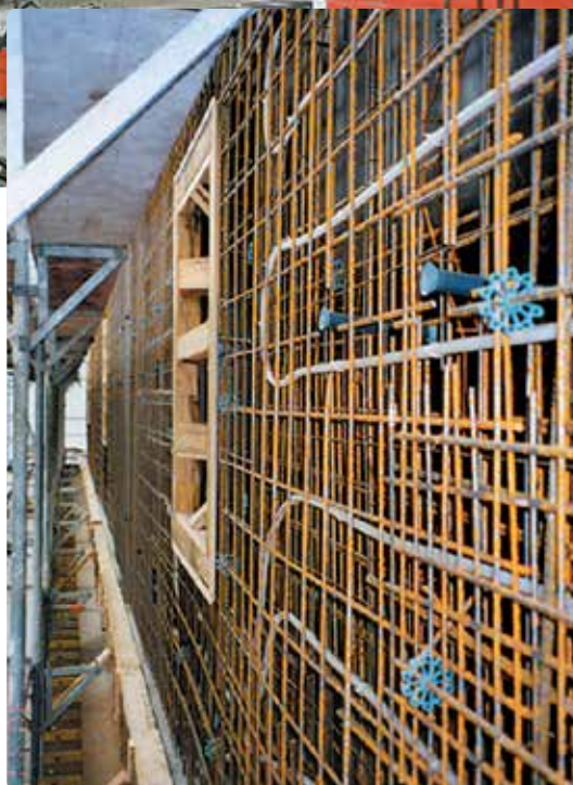
Montażowe umiejscowienie modułów
