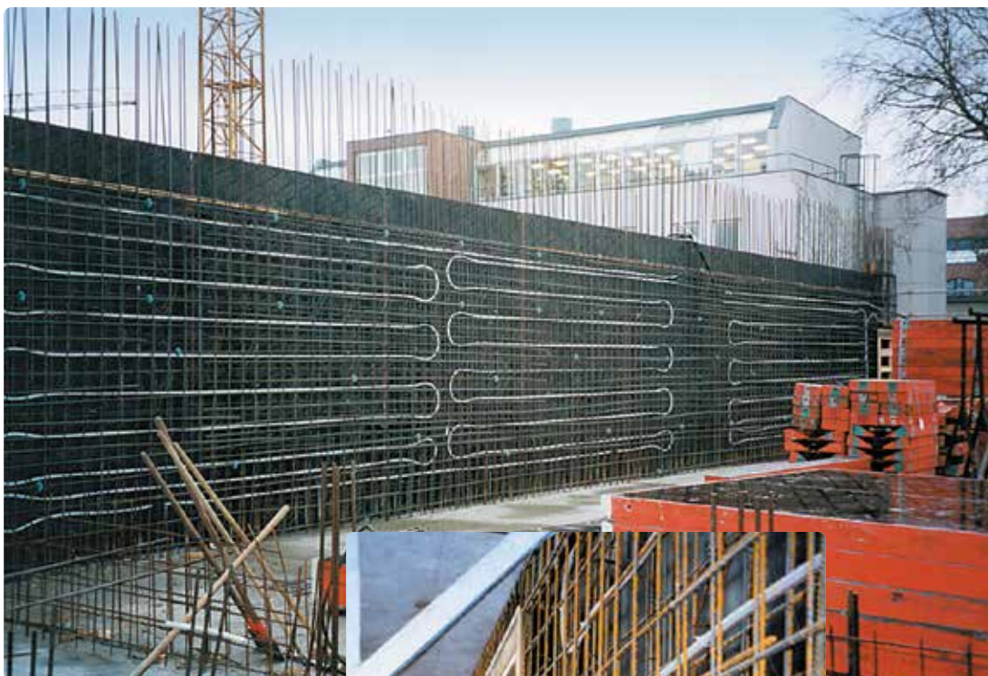
Moduły Uponor Contec w ścianach – budynek ORB Radio w Brandenburgu
