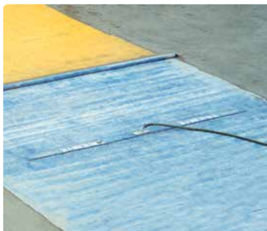
Rodzaj dywanu próżniowego, który ma osuszać powierzchnię betonu.
