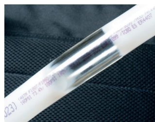
Los pinzamientos que se puedan producir en la tubería, se reparan fácilmente con un decaador de aire.
