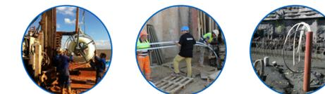
Instalação de sondas geotérmicas Uponor Geo Vertis (PEX).
