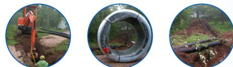
Distribuição de água para aquecimento com tubos pré-isolados Uponor Ecoflex.
