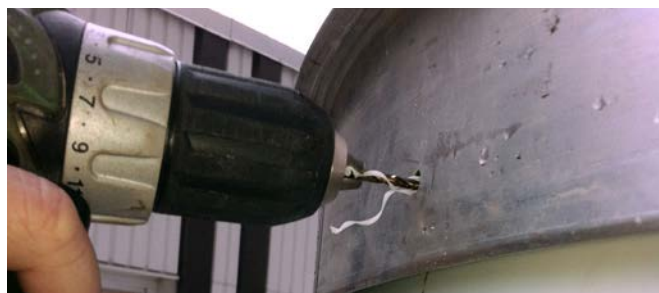
Puurige torni augud, et kinnitada päis torni külge.
