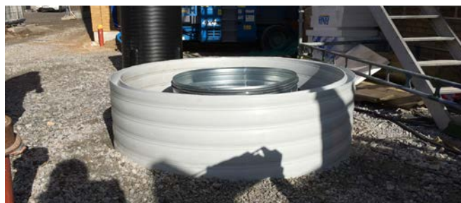
Olge kombipäist paigaldades hoolikas ja jälgige, et torni õhustoru oleks ühendatud päise keskel paikneva õhustuskanaliga.
