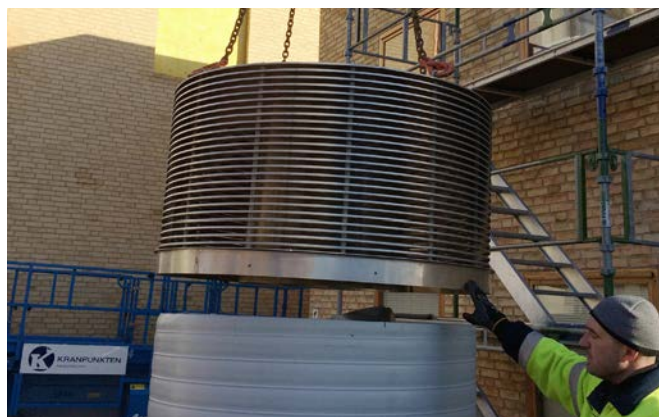
Kinnitage päise aasad tõsteseadme külge ja tõstke päis kohale.
