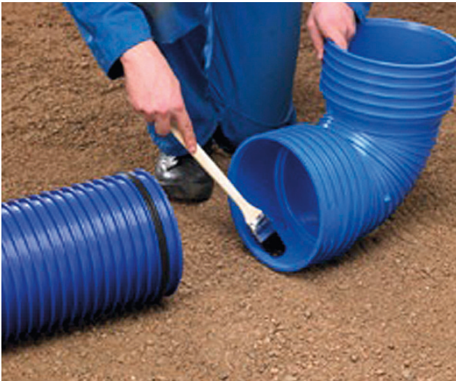
1. Paigaldage tihendusrõngas toruotsast lugedes teise soonde. Kandke nii muhvile kui ka tihendusrõngale Uponori liugainet.
