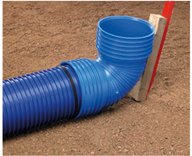
2. Selleks et torupõlve mitte kahjustada, kasutage montaaži ajal toetuseks puitklotsi. Abivahendiks sobib kang või labidas.
