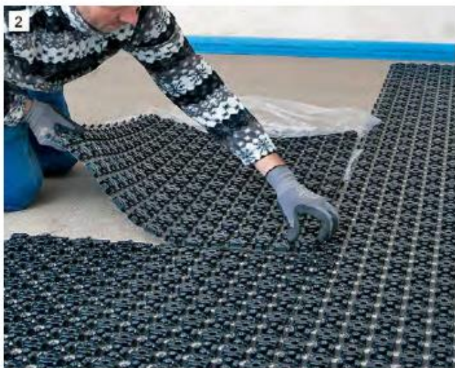
2) Peale aluspinna ettevalmistust (nakkekrunditud betoon või põrandaplaat) paigaldage Minitec plaadid vastavalt ruumi kujule jättes seinte äärtesse umbes 5 cm vahe ning kinnitades plaadid üksteise külge kolmnurksete plaadi osade abil.
