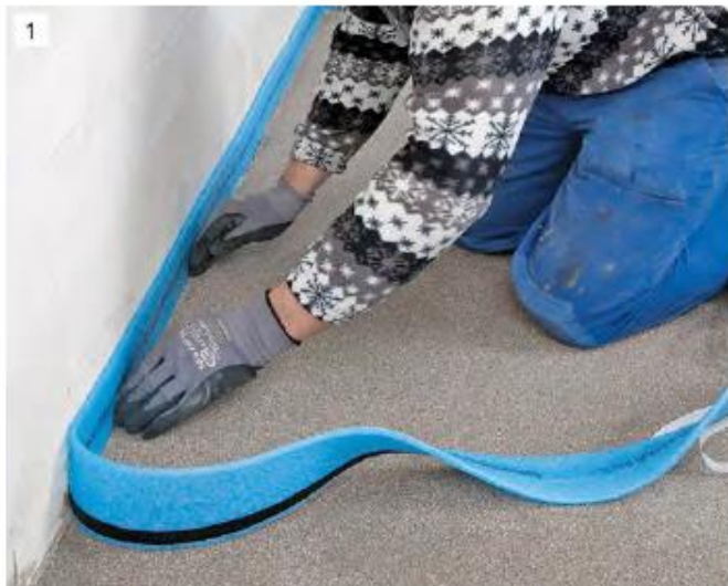
1) Uponor Multi liimikihiga ääreniba tuleb paigaldada kõikide seinte ja muude vertikaalsete pidadele ilma katkestusteta.
