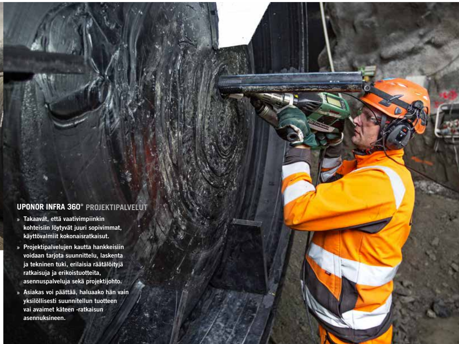
Uponorin ammattilaiset hitsasivat 175-metrinen Weholite-putken 8-metrisistä osuuksista.
