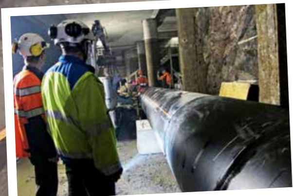
Hitsattava muoviputki oli paras vaihtoehto urakkaan, sillä sen sai ohjattua yhtenä pituutena tunneliin.
