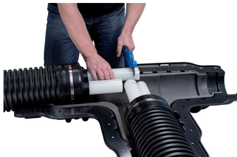
Bild 1. Kapa röret med verktyg avsett för PEX, viktigt att snittet är rakt.
