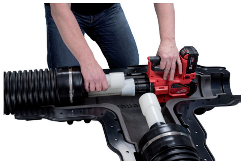
Bild 2 Expandera röränden tillsammans med ringen. Autoroteringsfunktionen säkerställer en jämn expansion.
