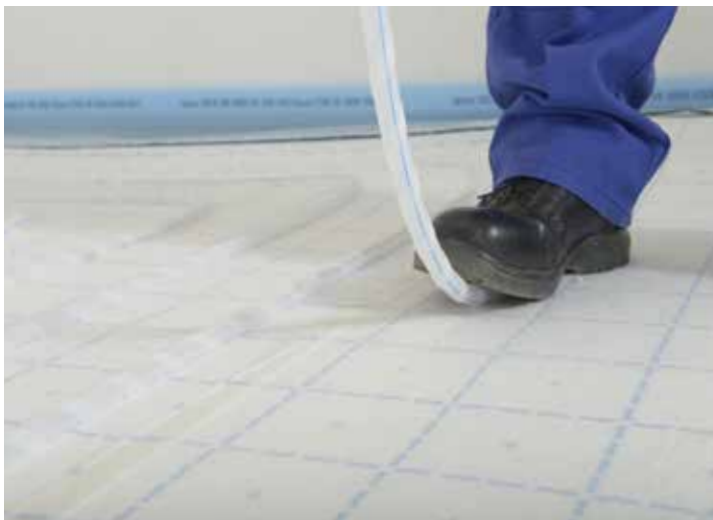
La posa avviene con una leggera pressione del piede sul tubo. L'attrito fa sì che non si sposti più dalla sua posizione
