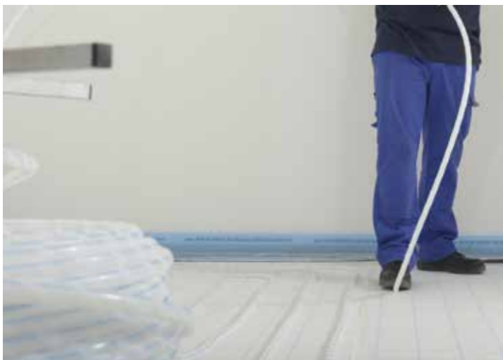
Successivamente si riposiziona il tubo fissandolo con la consueta pressione del piede, potendo contare sulla stessa aderenza della prima posa
