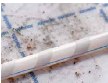
L'adesione del tubo rimane perfetta anche col normale sporco di cantiere
