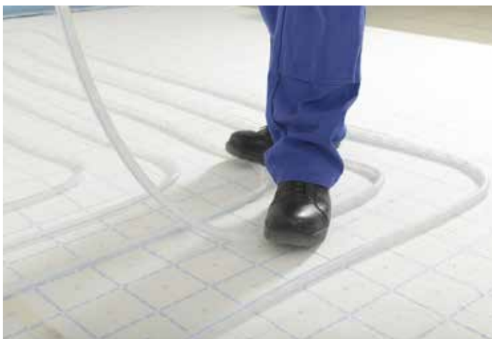
Nel caso di errato posizionamento o di ripensamenti, basta tirare il tubo verso l'alto col minimo sforzo perché si sollevi dal pannello
