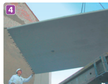
Tepelne aktívne betónové prvky sa dodávajú na stavenisko.
