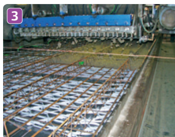
Nanášanie betónu. Od tohto okamihu sú všetky stropné aktívne komponenty chránené pred ďalším použitím na stavbe.
