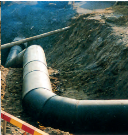
Uusi PE-putki 800 mm asennettuna vanhan putken paikalle.
