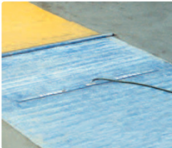
Vakuumska preproga za izsušitev površine betona.
