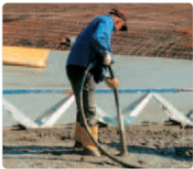
Zgoščevanje betona z uporabo vibracijskih cilindrov
