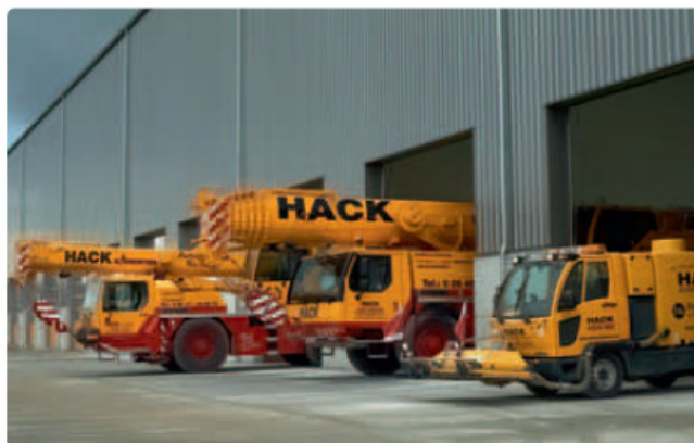
Vzdrževalni objekt težkih vozil Hack, Windhagen, Nemčija. Opremljen z Uponor industrijskim talnim ogrevanjem.
