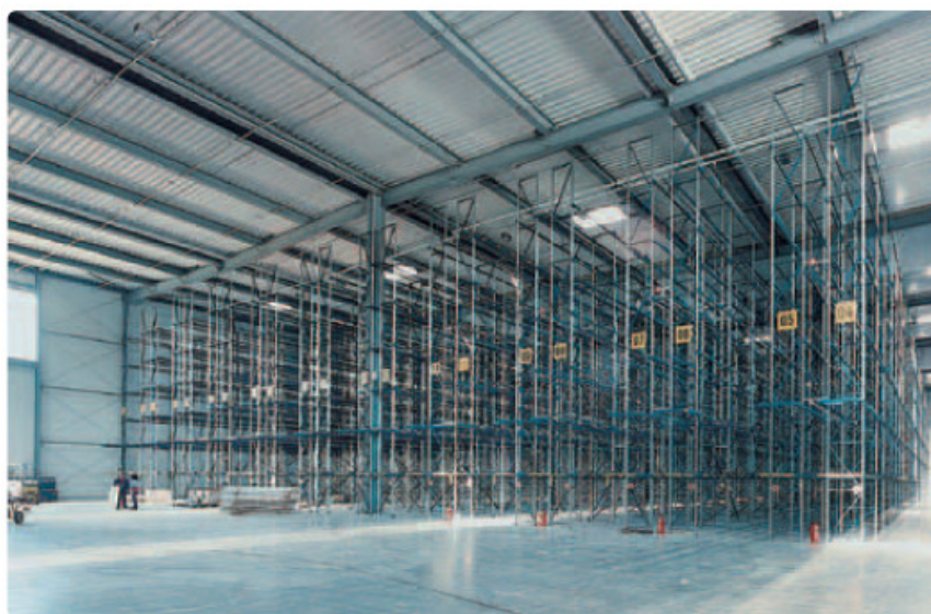
20.000m 2 Uponorjevega industrijskega talnega ogrevanja v visoko-regalnem skladišču v mestu Hückelhoven, Nemčija
