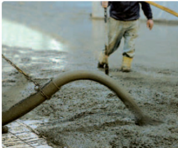
Prednapet beton z ojačitveno mrežo.
