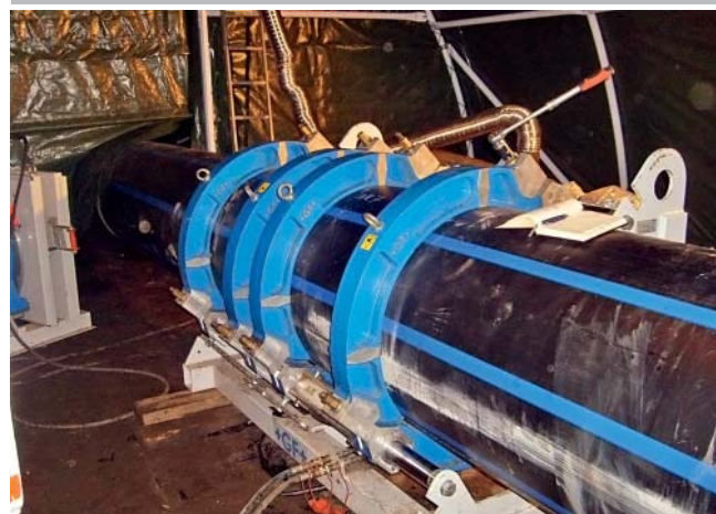
Fot. 3. Próbné zgrzewy w hali namiotowej
