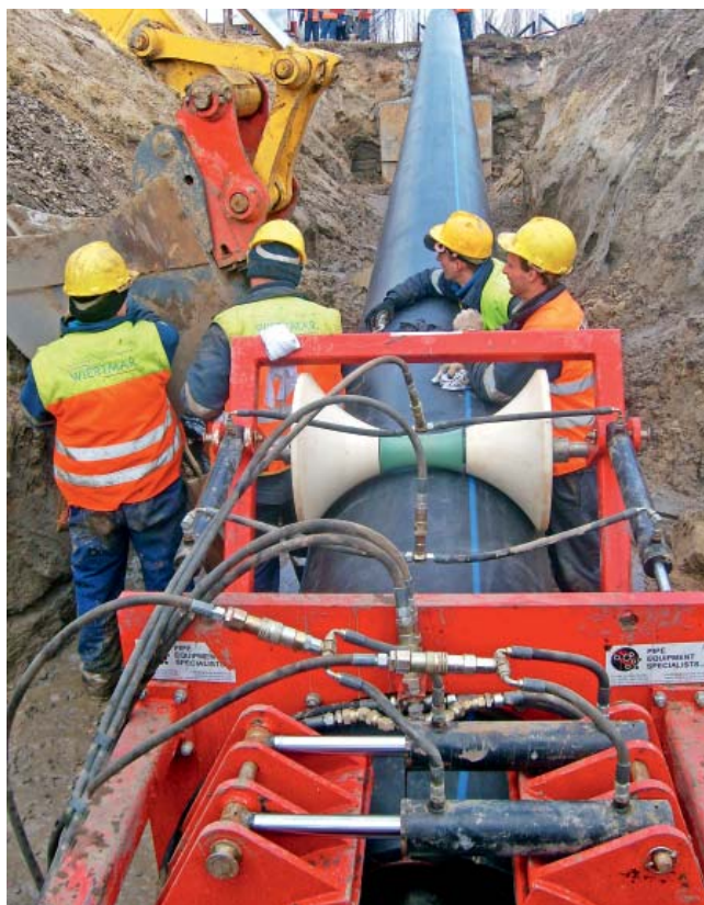
Fot. 4. Pierwsze metry rury przechodzą przez reduktor
