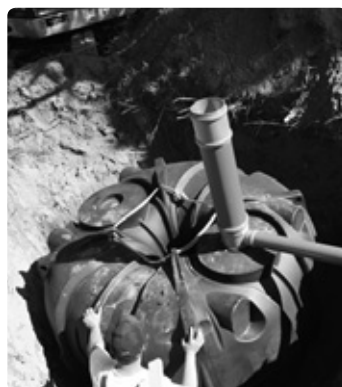
Tilslutning af afløbsrør
