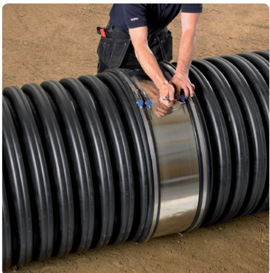
3. Lai terasriba asetatakse kummiprofiili keskjoonele jääva soone ümber. Seejärel paigaldatakse kitsad terasribad. Esmalt tuleb pingutada kitsad terasribad ja seejärel lai terasriba.
