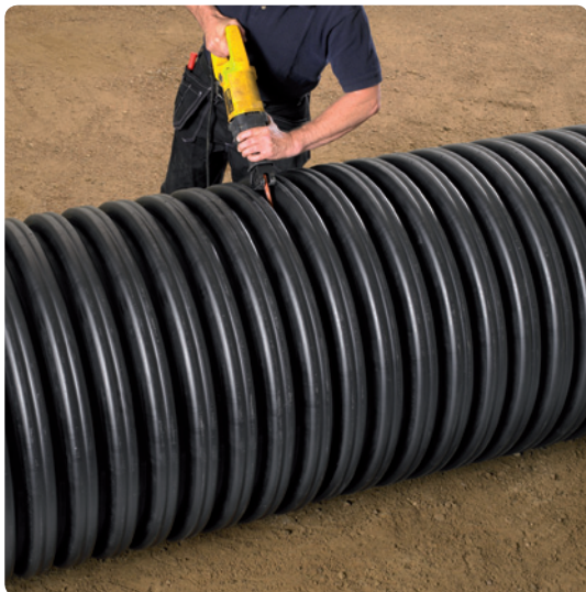
1. Toru lõigatakse kahe ribi vahelt nt tiigersae abil parajaks.
