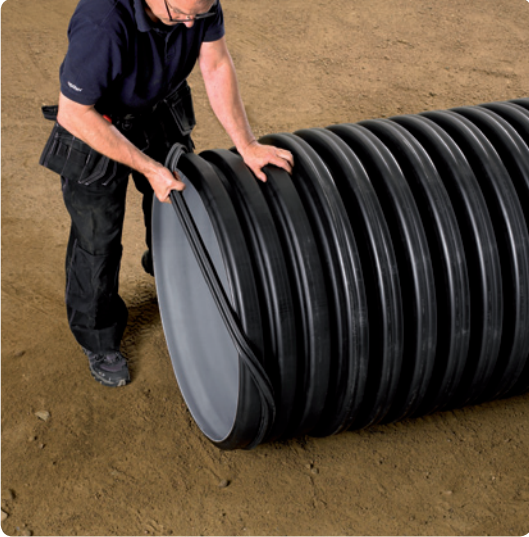
1. Tiheda ühenduse saavutamiseks paigaldatakse toru esimesse ribivahesse tihendusrõngas. NB! Tihendusrõngas on mõeldud ainult tehases valmistatud otsaku paigaldamiseks
