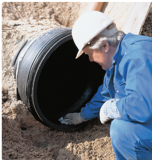
2. Otsak, muhv ja tihendusrõngas puhastatakse liivast ning kruusast.
