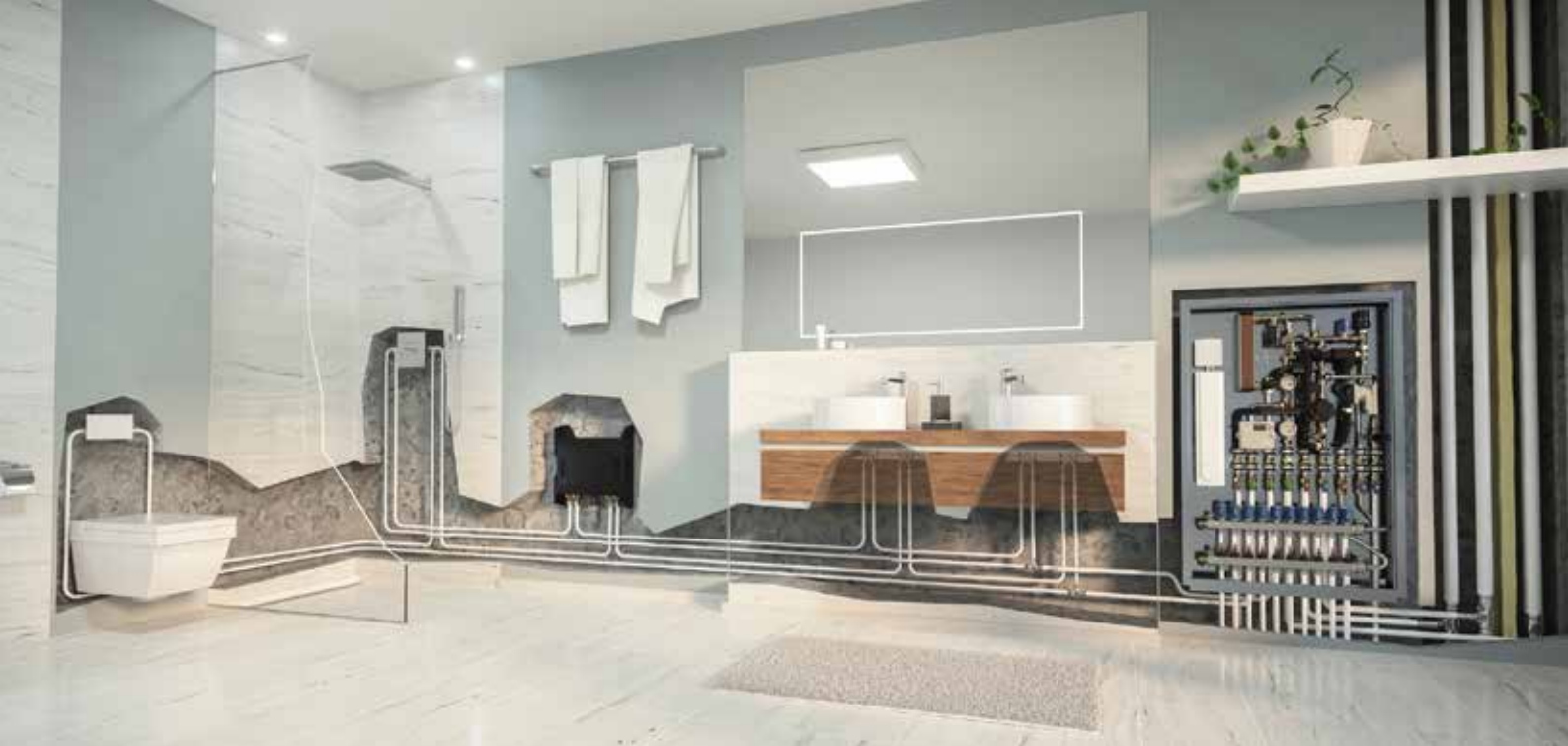
Abb. 1: Die Kombination aus dezentraler Trinkwassererwärmung im Durchlaufprinzip, Durchschleif-Ringinstallation und bedarfsgerechter Hygienespülung springt Hygiene, Komfort und Energieeffizienz sicher in Einklang.
