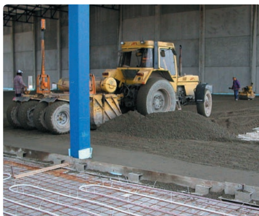
Použití válcově zhutněného betonu.
