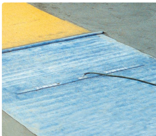
Vakuový koberec k vysoušení betonového povrchu.
