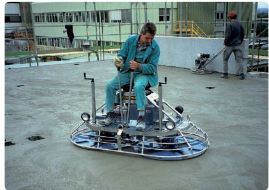
Vykonové hladitko rotorového typu na uhlazení betonových povrchů
