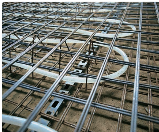
Vyztužený beton se zpevněním pomocí kari sítí.
