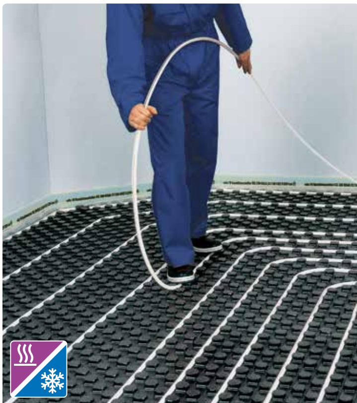
Cu Uponor Tecto montajul devine ușor și sigur și poate fi făcut de către un singur instalator. Țevile PE-Xa se apasă cu piciorul și gata.
