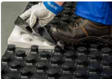
Folia de polistiren vacuat oferă rezistență mecanică suplimentară și etanșare perfectă la umiditate
