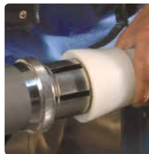
Inserire l'anello sul tubo ed espandere
