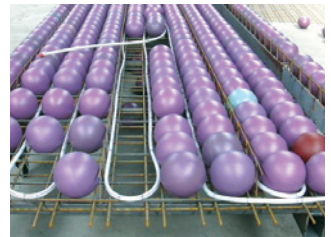
Cobiax® Module mit Uponor Contec.
