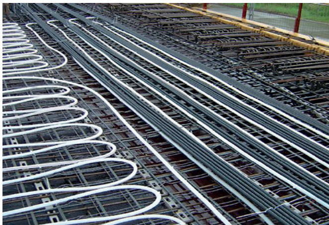
Die Uponor Contec Module werden in der Deckenmitte (statisch neutrale Zone) eingebaut.
