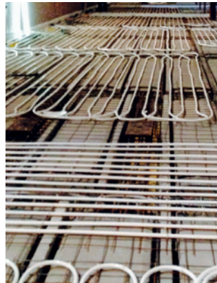
Installation des Uponor Contec Systems in eine Rippendecke.
