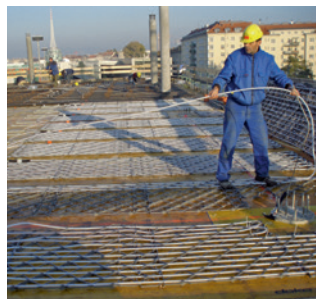
Alternativ: Verlegung der Uponor PE-Xa Rohre in Contec ON Leermodule auf der Baustelle.
