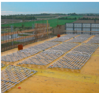
Anordnung der vorgefertigte Contec ON Module auf der Schalung gemäß Planung.
