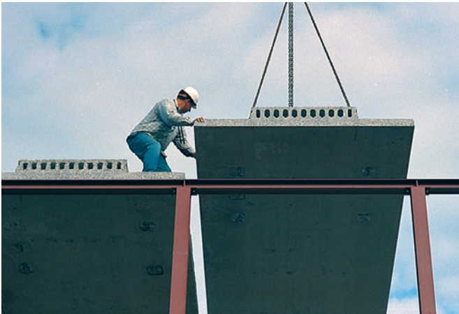
Montage der thermisch aktiven Betonfertigteile auf der Baustelle.
