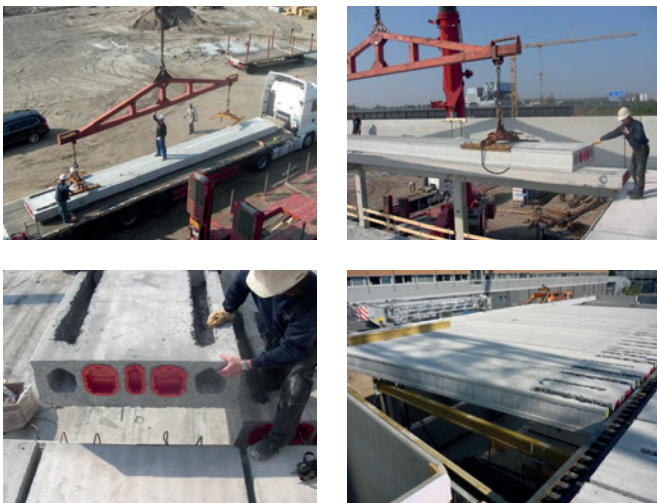
BubbleDeck® Module mit Uponor Contec.
