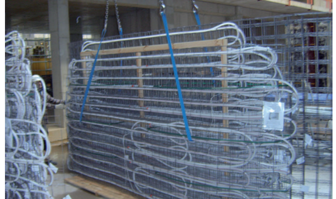
Contec Modulpaket mit senkrecht stehenden Contec Modulen.
