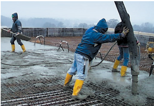
Betonieren der Decke vor Ort.
