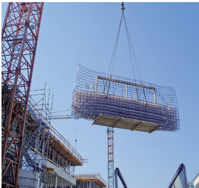
Fachgerechte Kranung eines Contec Modulpakets mit senkrecht stehenden Modulen.
