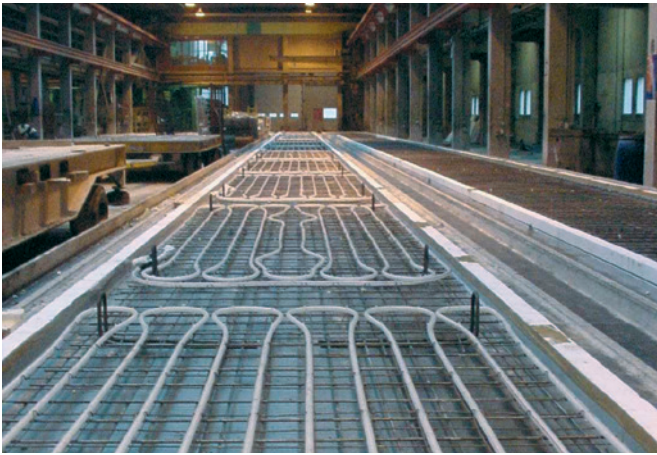
Einlegen der Contec Module in das Betonfertigteil beim Hersteller.
