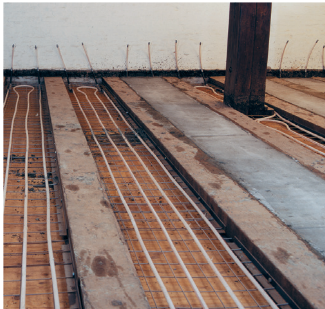
Contec Verlegung im Balkenzwischenraum der Decke.
