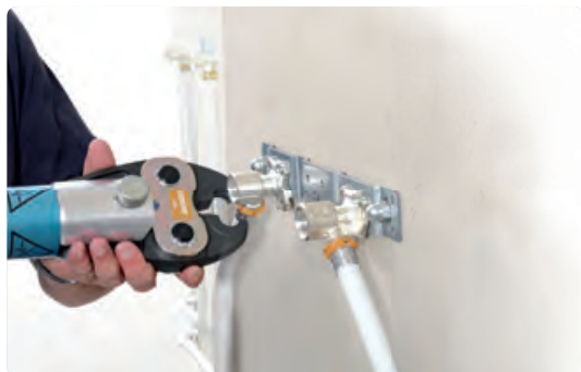
Vorgefertigte Montageeinheiten in unterschiedlichen Ausführungen ermöglichen einen schnellen Baufortschritt
