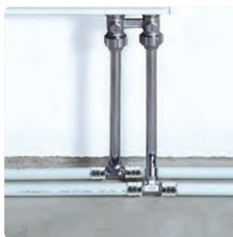
Heizkörperanschluss aus dem Boden mittels Uponor Press-Anschlusswinkel
