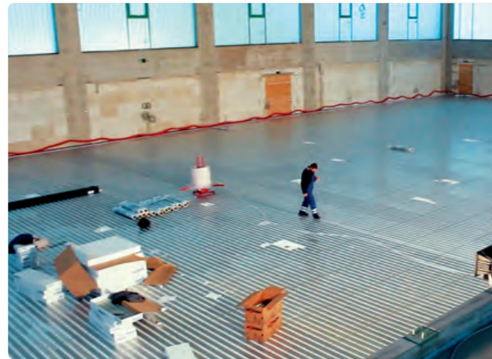
Montage einer Sportbodenheizung in der 3-Feld Halle des Johannes-Kepler-Gymnasium Ibbenbüren
