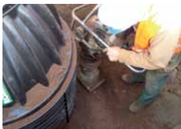
Komprimering med maskin
