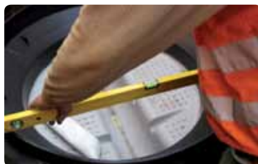
Kontrol af installation
