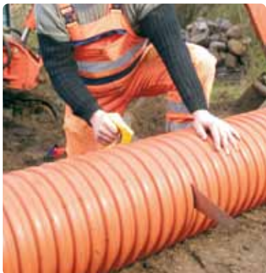
3. Det korrugerede opføringsrør i PP afkortes i den ønskede længde med en sav.
