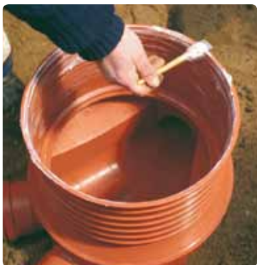
5. Brøndmuffen og tætningsringen påsmøres glidemiddel.
