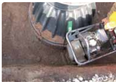
Komprimering med maskin
