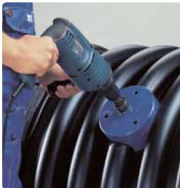
1. Udboring til tilslutningen foretages med hulbor.
