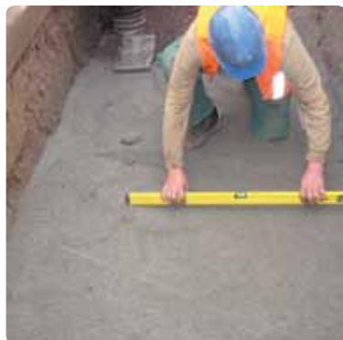
Afretning af udjævningslag
