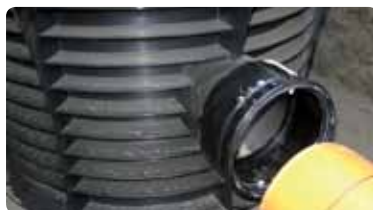
Montering af rør
