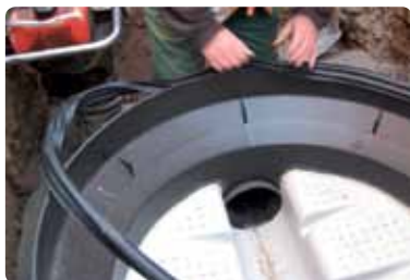
Montering af tætningsring
