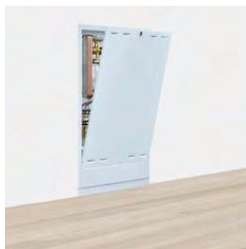
Una vez realizadas las conexiones, se coloca el marco y la tapa.
