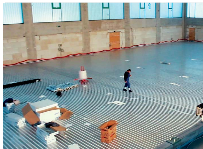
Montaggio di un riscaldamento per pavimento sportivo nel palazzetto dello sport a 3 campi da gioco del liceo Johannes- Kepler di Ibbenbüren
