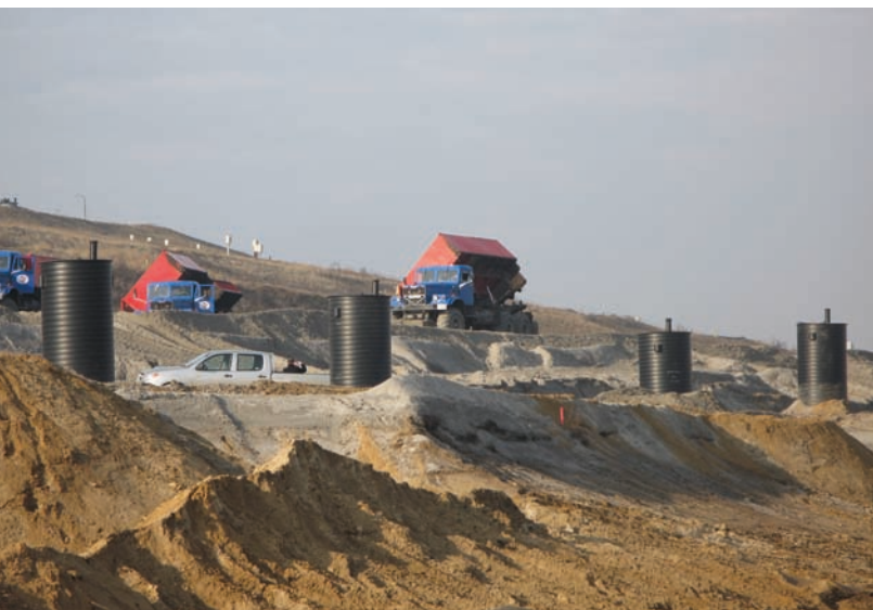
System drenażu obwałowań składowiska Żelazny Most
