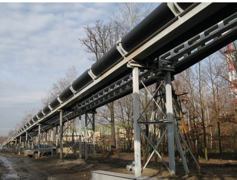
Transport odpadów poflotacyjnych rurami WehoPipe DN 900
