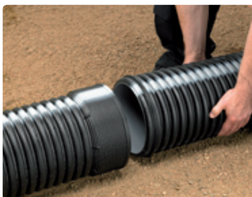
2. Ved tett rørsystem monteres pakningen som settes i det første sporet fra spissenden. Pakningen monteres med de to profilene ned i sporet.
