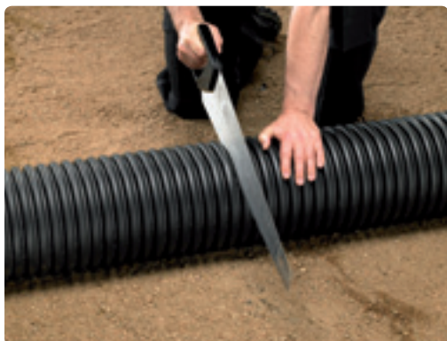
1. Røret kuttes mellom to riller med sag.
