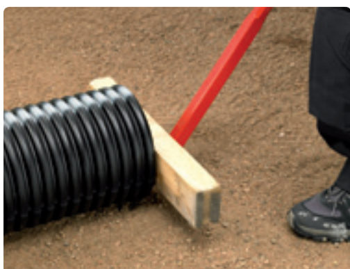
4. Røret skal monteres i bunnen av muffen. Man kan lage et innstikkmerke, slik at man er sikker på at man har nådd bunnen med spissenden.
