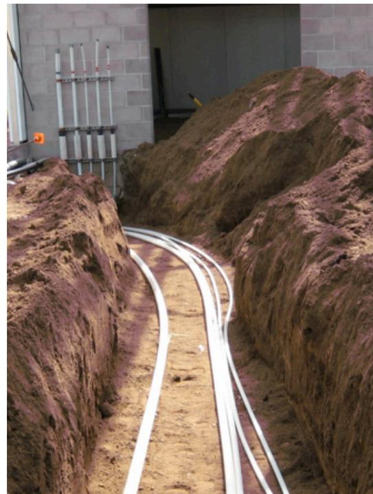
**Figure 6-23 : PEX Uponor sous le niveau du sol**
