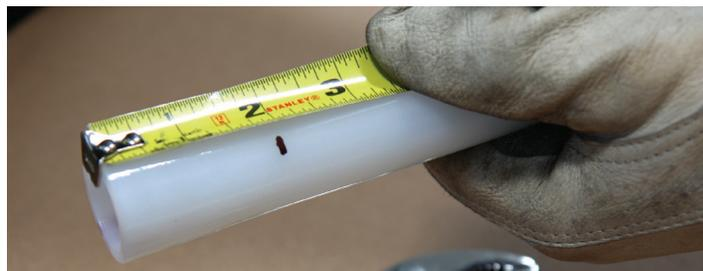
Figure 2-38 : Marquer l'extrémité du tuyau
