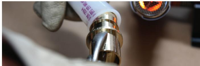
Figure 2-36 : Tourner le tuyau de droite à gauche
