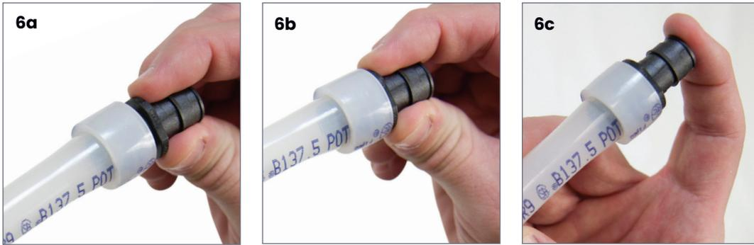
Figure 2-5 : Raccord ProPEX inséré dans un tuyau PEX de ½"
