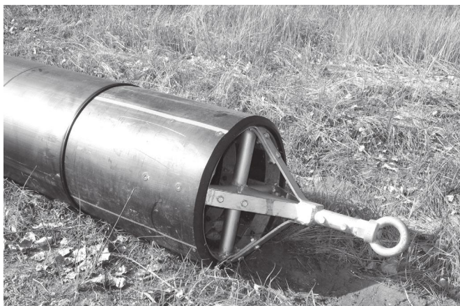
Po wciągnięciu całego odcinka rury PE do naprawianej rury, pomiędzy wykopami startowym i końcowym głowica jest odcinana od wciągniętej rury i może być wykorzystana ponownie przez jej dogrzenie do następnego wciąganego odcinka.
