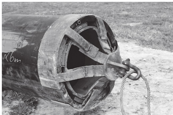
W trakcie wciągania należy zabezpieczyć rury PE przed kontaktem z ostrymi krawędziami rury osłonowej i innymi ostrymi elementami, jeżeli takie mogą wystąpić na drodze przeciąganych rur.
