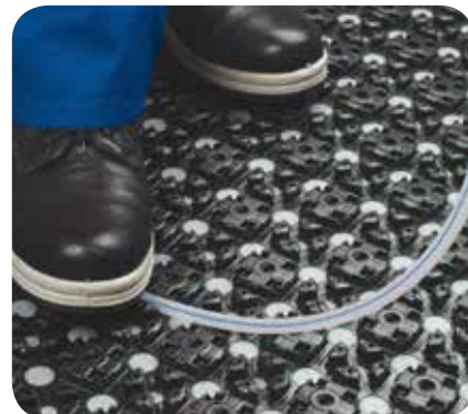
Uložení potrubí zvládá jeden člověk - úspora nákladů
