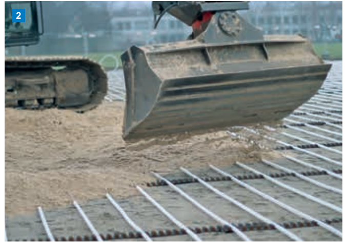
Die robusten 5-Schicht Uponor PE-Xa Rohre erlauben sogar den Überkopfeinbau der Drain- und Rasentrageschicht.
