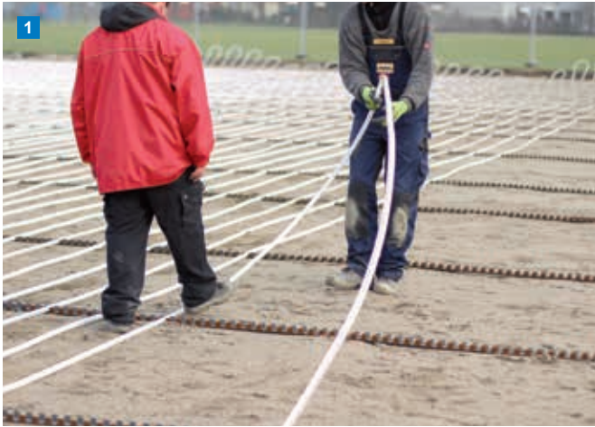
Verlegung der Tragschienen und der Uponor Neva Systemrohre im berechneten Verlegeabstand auf dem vorbereiteten Untergrund.
