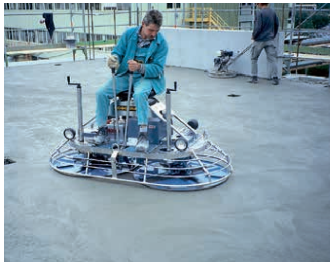
Rotor-Plan-Glätter zum Glätten von Betonoberflächen
