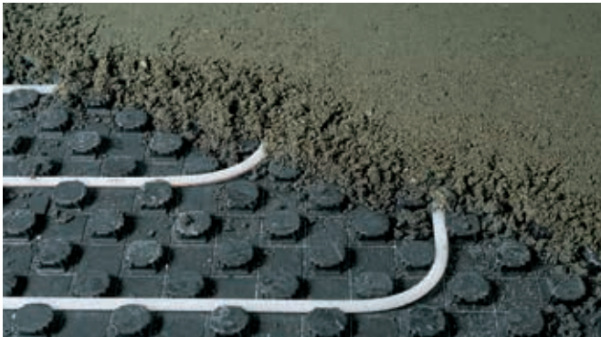
Uponor Multi Estrichkomponenten vergüten einen Standard-Zementestrich nach DIN 18560 zu einem Heizestrich – für eine optimale Wärmeübertragung, schnelle Abbindung und hohe statische Belastbarkeit.
