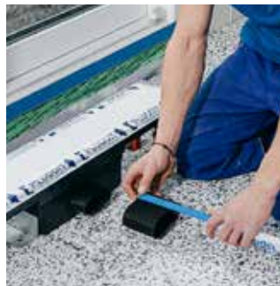
Zuschneiden eines PluggFlex-Kanals Typ PK 150 auf den passenden Abstand
