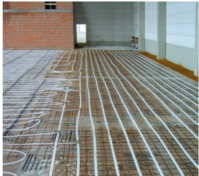
Anschluss der gleichlangen Heizkreise an eine Uponor Tichelmann Verteil-/Sammelleitung
