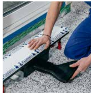
Einstecken des Pluggit Comfort Air Adapters
