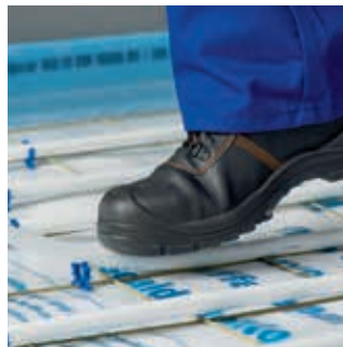
Die Uponor Comfort Pipe PLUS Rohre werden anschließend in die Rohhalter eingedrückt.
