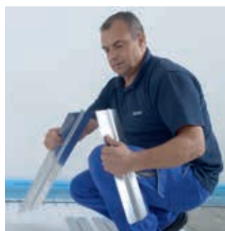
Bei Bedarf können die Siccus Wärmeleitlamellen an den Vorstanzungen werkzeuglos gekürzt werden.
