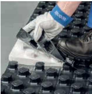
Die hinterschäumten Tecto Noppenplatten sind hervorragend begehbar und werden über die überstehenden Randnoppensenreihen dicht miteinander verbunden.
