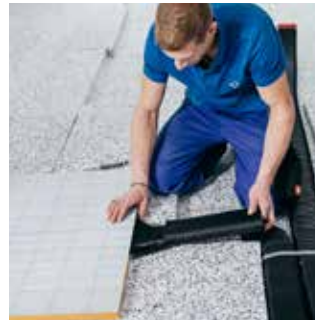
Zuschneiden eines PluggFlex-Kanals Typ PK 150 auf den passenden Abstand zum Pluggit Zuluftkanal
