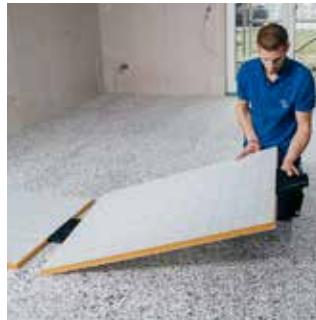
Einstecken des Pluggit Comfort Air Adapters
