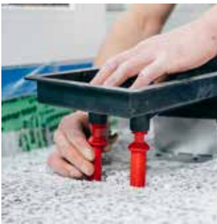
Montage der Pluggit Zuluftauslässe
