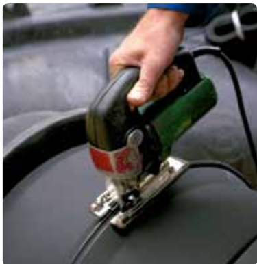
10 a. Opføringsrøret saves over i sporet.
