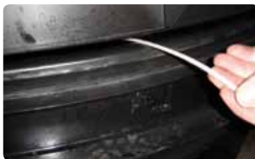
Undgå loftflomme ved brug af kabelbinde
