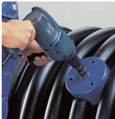
1. Udboring til tilslutningen foretages med hulbor.
