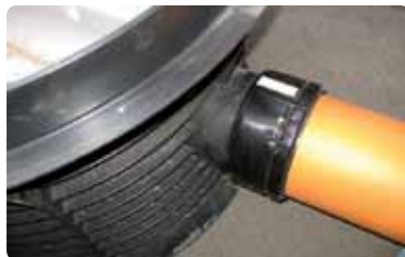
Rør monteret i muffe
