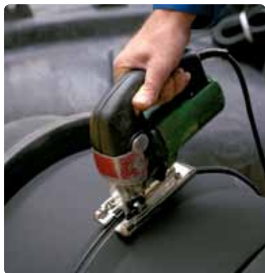
10 a. Opføringsrøret saves over i sporet.
