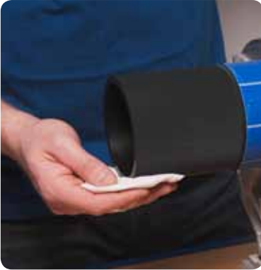
5. Røret aftørres med rensesvæske inden svejsning.
