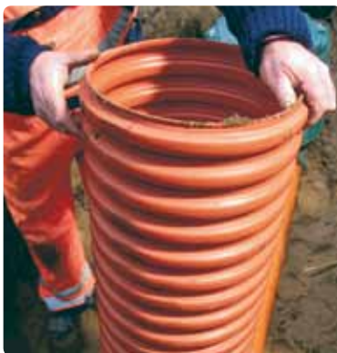
6. Opføringsrøret monteres i muffen.
