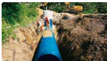
Fyldning, kontrol af riller og tryktest.
