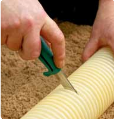
1. Røret saves eller skæres over mellem ribberne.
