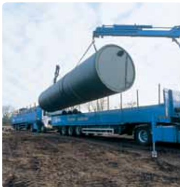
Aflæsning af 30 m 3 bundfældningstank.
