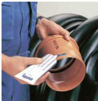
3. Glidemiddel påføres mufferrøret.
