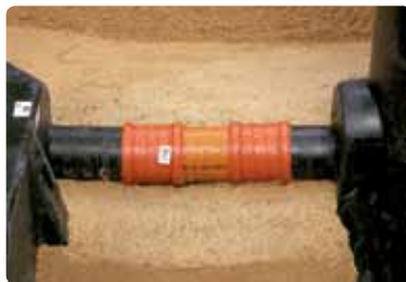
Fotoet viser samlingerne af forbindelsesrøret mellem tankene.
