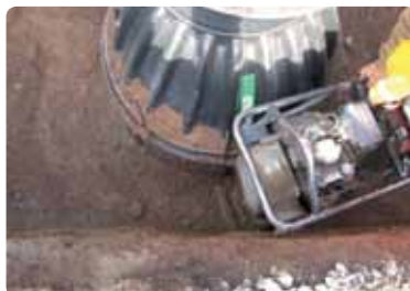
Komprimering med maskin
