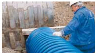
Kontrolleret montering med gravemaskine.
