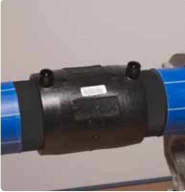
6. Montere svejsekabler, og muffen er klar til svejsning.
