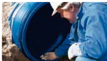
Kontrol og smøring af pakning.
