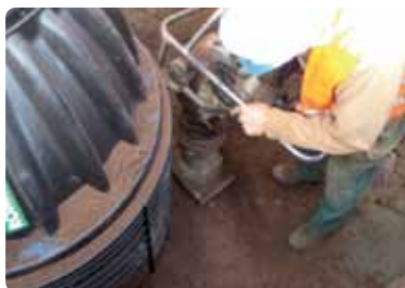
Komprimering med maskin
