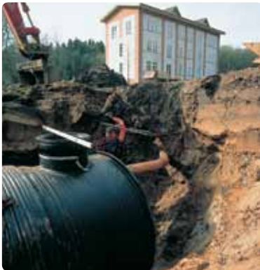
20 m 3 bundfældningstank installeres i Lerbæk Mølle, Vejle.
