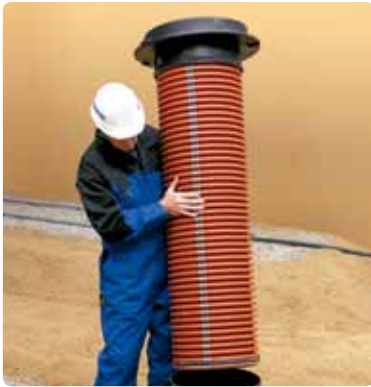
10 e. Forlængerrøret monteres i brøndbunden.
