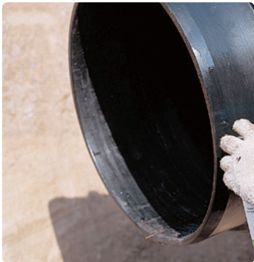
1. Enne paigaldust tuleb kontrollida, et toru poleks saanud veo- või muid kahjustusi.
