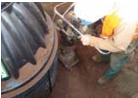
Komprimering med maskin
