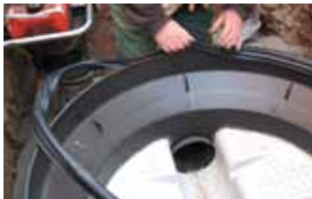
Montering av rör
