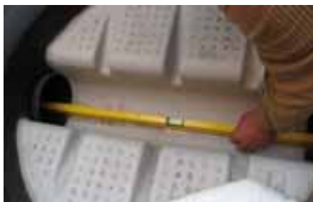
Kontroll av fall
