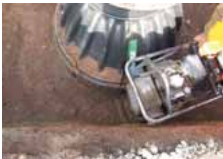
Komprimering med maskin
