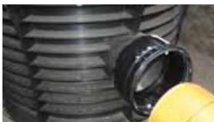
Montering av rör
