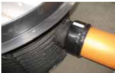
Rör monterat i muffen
