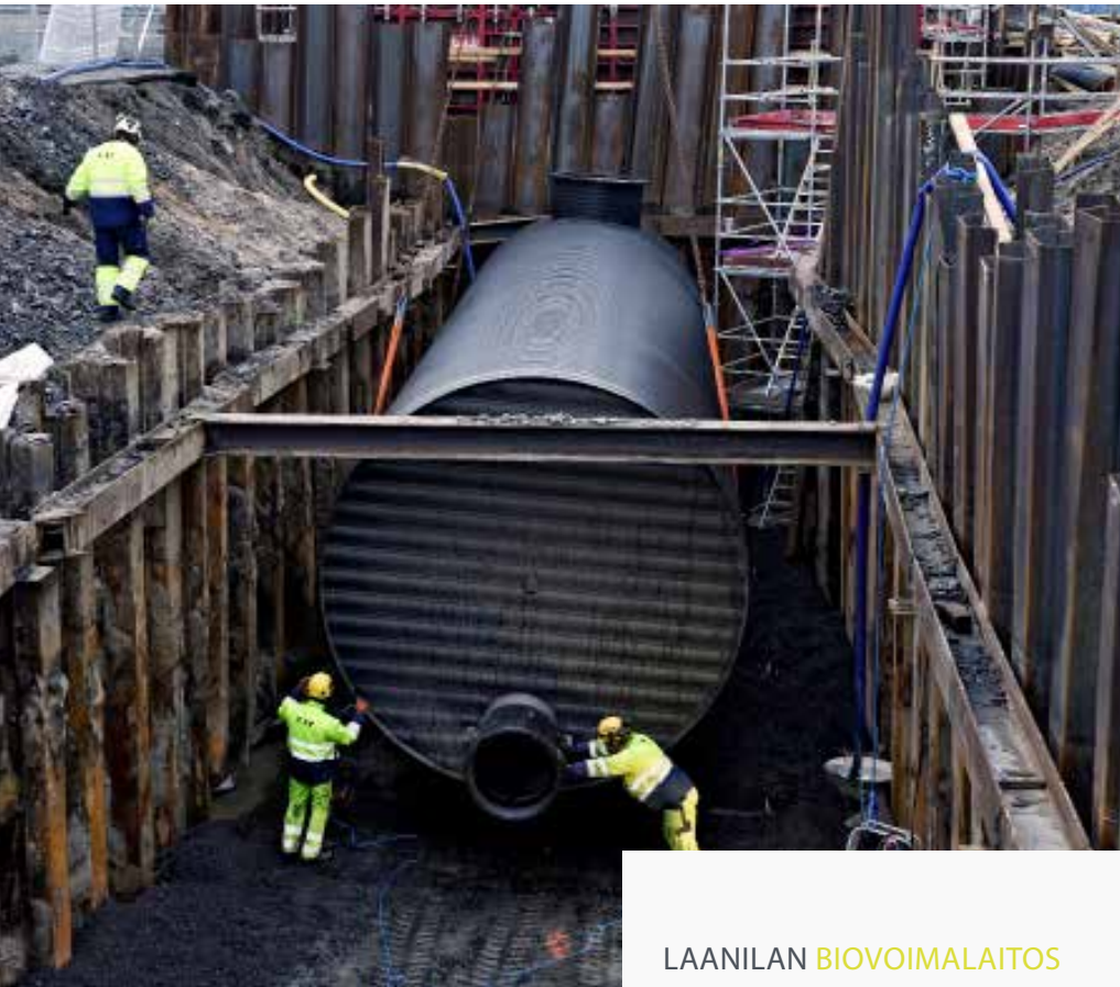
YIT:n työpäällikkö Mika Stillin mukaan kevyt ja kestävä Weholite sopii hyvin säiliökäyttöön.
