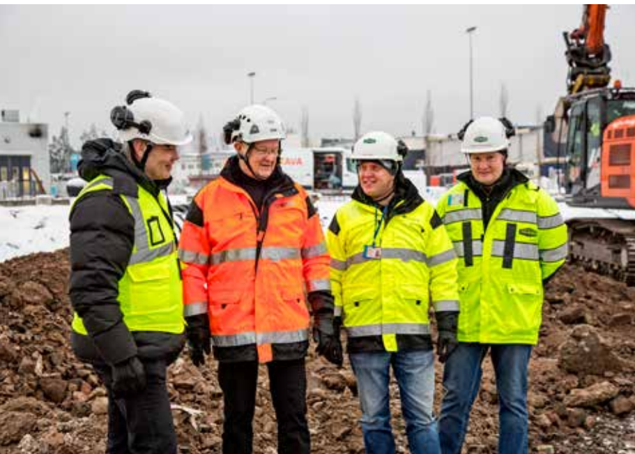
Tomi Lempinen (vas.) Uponorilta, Tapio Kalliola EKE-Rakennuksesta sekä Tommi Heikkinen ja Markku Hurskainen Hyvinkään Tieluiskasta ovat tyytyväisiä nopeasti ja helposti sujuneeseen asennukseen.
