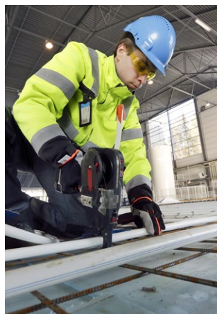
Uponor Quattro -järjestelmän asentaminen on nopeaa. Kuva: Pekka Mäkyinen
