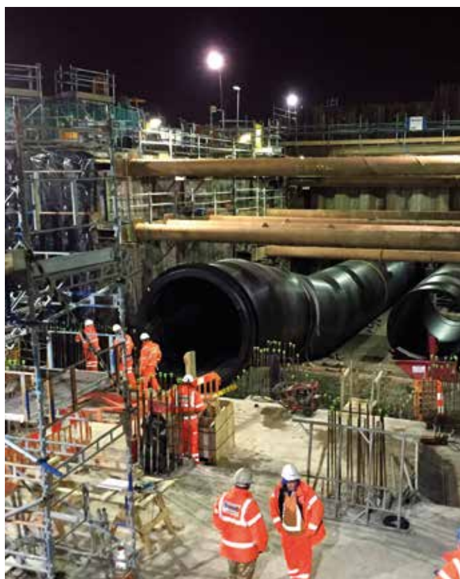
Beckton, London: Utlopp för renat avloppsvatten. Projektet innefattade två 440 m Weholite ID 3 000 mm rör, konstruktionstekniskt arbete, materialleveranser, svetsarbeten, igenfyllning av profiler, PE-boxar och övervakning av installationsarbetet. På grund av den nödvändiga mängden kringfyllning användes LP SN6 för landsektionen medan den marina installationen utfördes med SN4.
