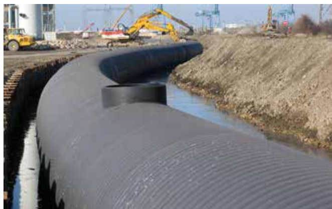
Fos-sur-Mer, Frankrike: Weholite är ett av få rör i världen med dimensioner över DN/ID 2 000 mm.
