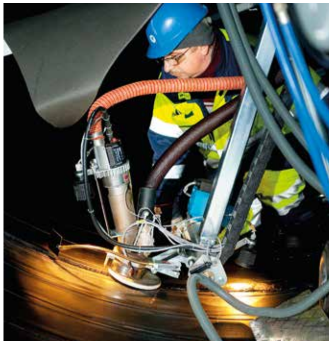
Maskin för invändig extrudersvetsning. Allt arbete ska utföras av utbildad personal.
