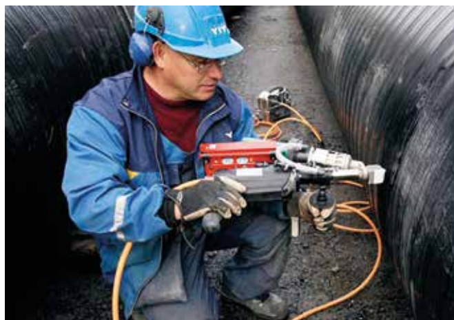
Handextruder. Handextrudern är särskilt lämpad för att göra gängkopplingar vattentäta.
