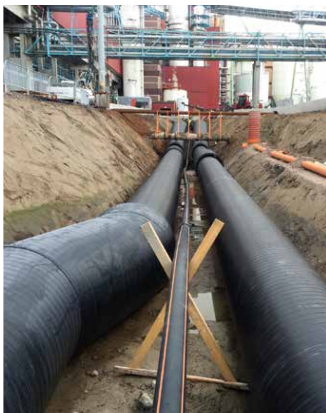
På grund av den höga trafikbelastningen användes Weholite som skyddsror vid SCA-massafabriken i Sverige. Inuti Weholite-rören sitter styva DN 900 mm rör för huvudprocessvattnet.
