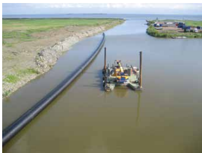
Sankt Petersburg, Ryssland: Utloppsledning till ett reningsverk. Uponor levererade 1 060 m DN/ID 1 200 mm rör- och svetsarbeten för det här projektet.
