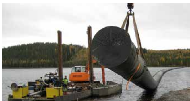
Talvivaaragruvan, Sotkamo, Finland: Uponor sänkte ned ett 250 m långt Weholite-rör DN/ID 1 600 mm som intagsrör för färskvatten.
