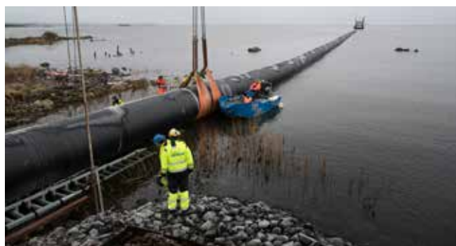
Nymölla, Sverige: Utbyte av utloppsledning och intagsledning för kylvatten för Stora Enso Nymölla Bruk. Nymöllas val av ledning föll på Weholite p g a att man kan profilylla ledningarna och på så sätt undvika externa betongvikter. Weholite dimension 1500 i 24 meters längder av en total sträcka av 3500 meter installerades.
