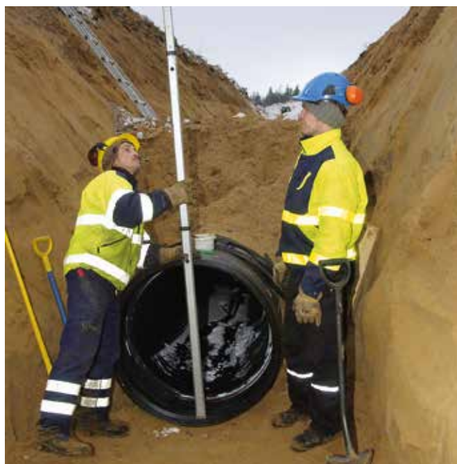
Riksväg 6 Koskenkylä – Kouvola, Finland: en gammal och farlig väg byggdes om till en modern väg med breda filer. Högre säkerhet och bättre trafikflöde. Weholite-rör i dimensionerna DN/ID 360–2 000 mm SN4 har använts som rörtrummor för huvud- och sidovägarna.
