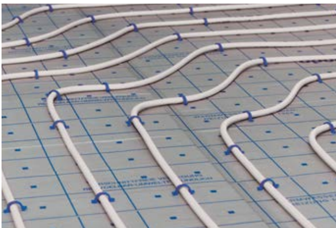
Dosljedan i jasan uzorak polaganja cijevi zahvaljujući iscrtanoj mreži polaganja i čvrstim Tacker pričvrstnicama za fiksiranje
