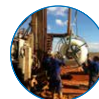
Instalación de sondas geotérmicas Uponor Geo Vertis (PEX-a)
