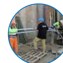
Instalación de sondas geotérmicas Uponor Geo Vertis (PEX-a)
