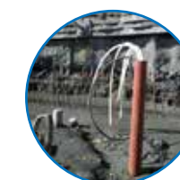
Instalación de sondas geotérmicas Uponor Geo Vertis (PEX-a)
