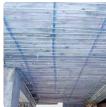
System podtynkowy Uponor na suficie
