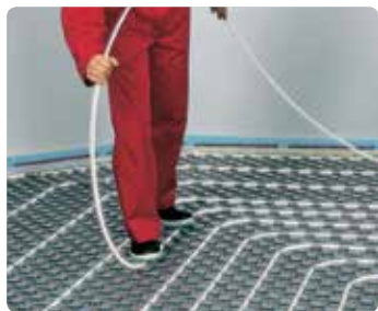
Panele Tecto do prostszego i jednolitego układania rurek
