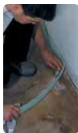
Uponor Minitec - montaż taśmy brzegowej
