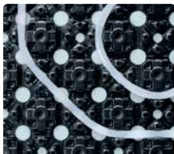
Rury PE-Xa montowane pod kątem 45°
