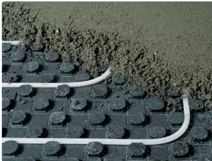
Zgodnie z DIN 18569 wylewki betonowe muszą być wzmocnione domieszkami Uponor
