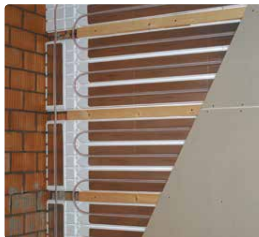
Montaż ogrzewania ściennego Uponor Siccus z płytami kartonowo-gipsowymi.
