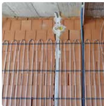
System podtynkowy Uponor na ścianie
